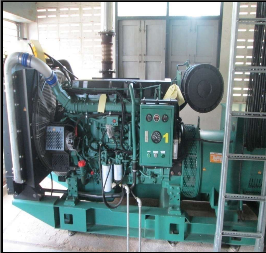
เครื่องกำเนิดไฟฟ้าสำรอง ขนาด 300 kW
